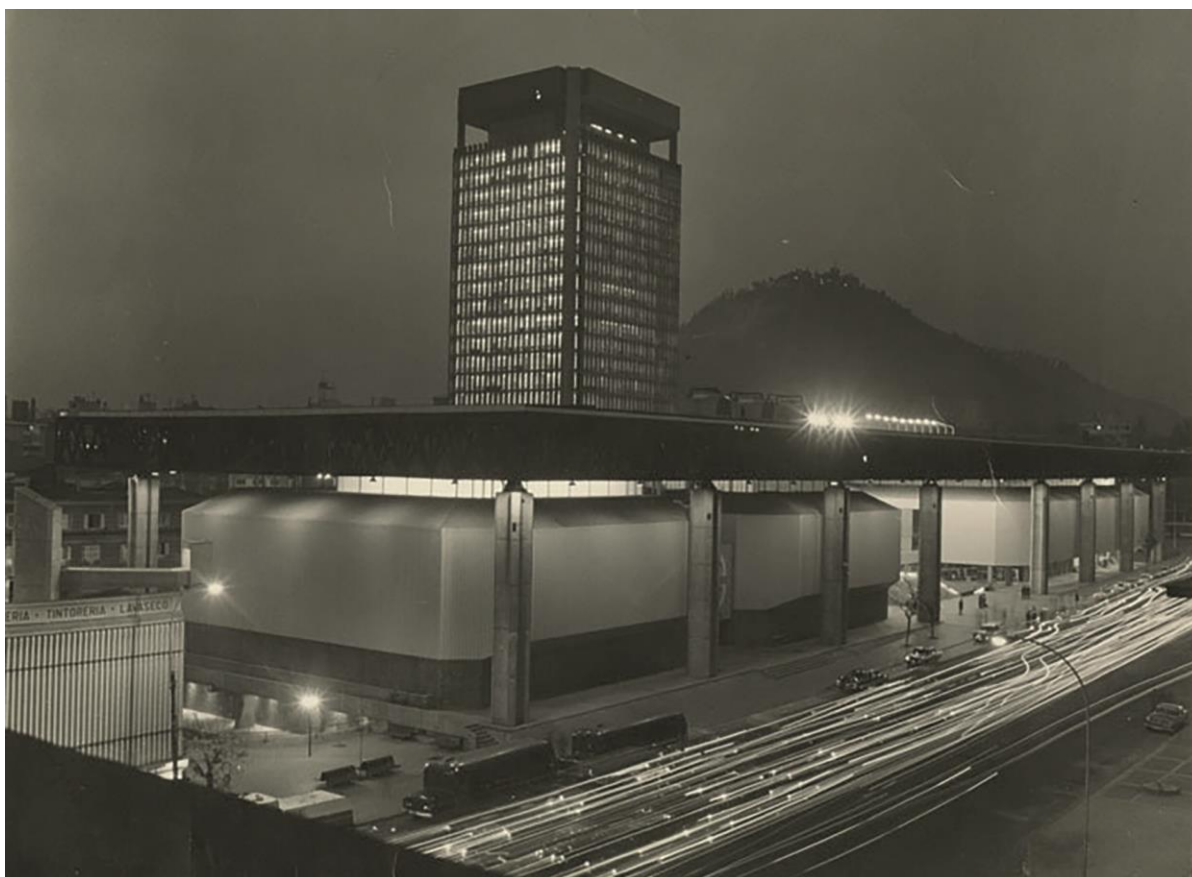
Figura 1: Edificio UNCTAD III o Diego Portales (ca. 1972-1975).
