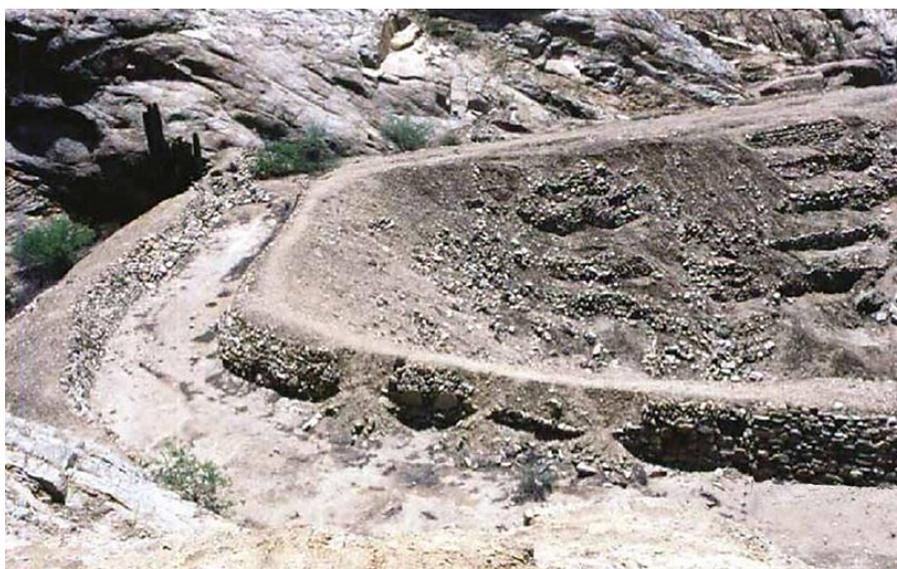
*Fig.2. Levantamiento de terrazas escalonadas para la construcción del acueducto del Cerro Tres Cruces, canal inter valle Chicama – Moche (Foto: J. Deza 2010).*
